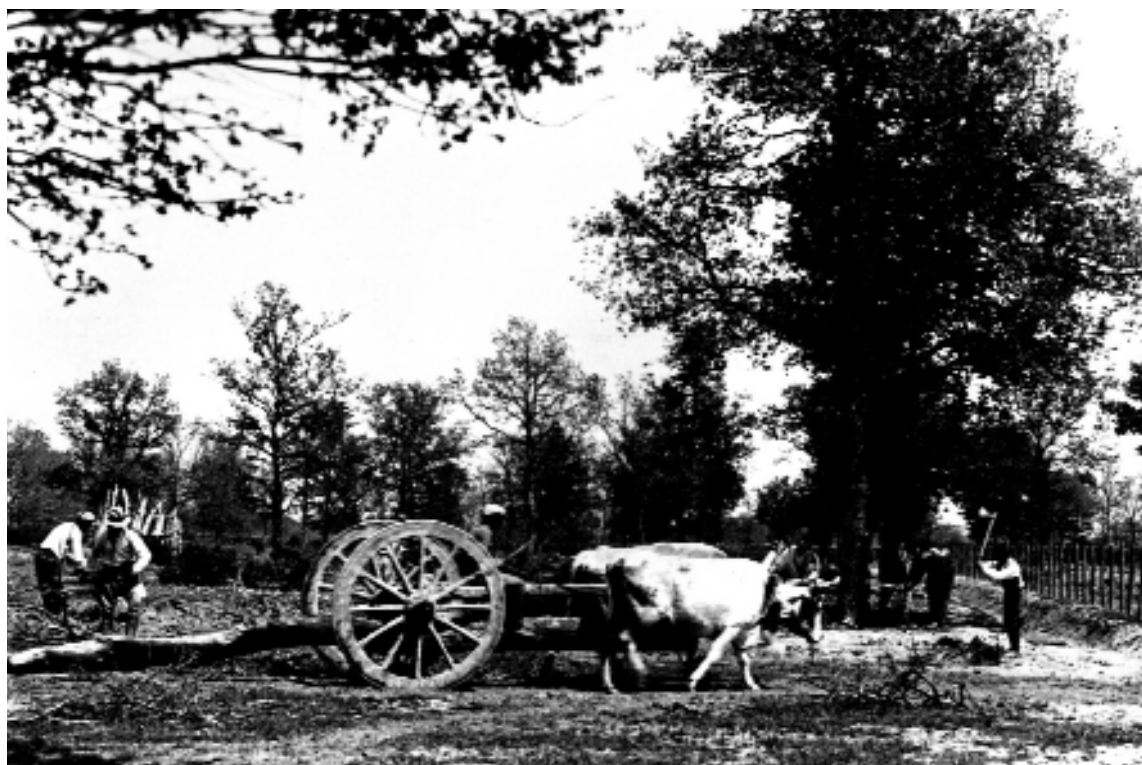
Lavori di disboscamento
