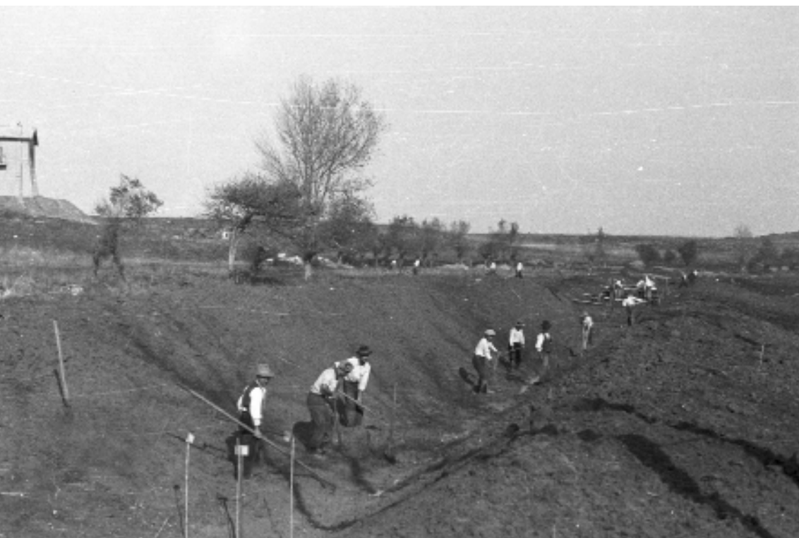
Lavori di scavo di un canale di drenaggio
